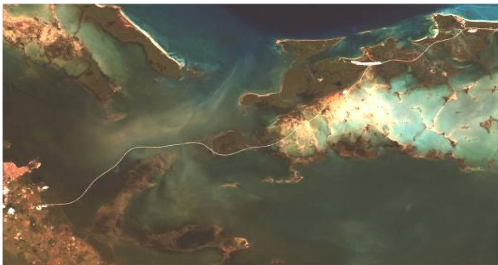
Fig. 4: Pedraplén Caibarién - Cayo Santa María.
